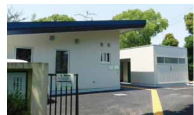
▲ 新しくなった管理棟とトイレ。
